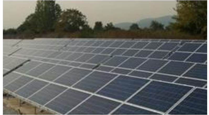
GÜRSU Municipality 96 kWp
