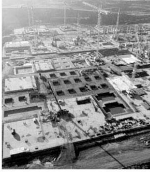
Istanbul'un kuzeyinde yapımı devam eden 3. havalimanı inşaatı sürüyor.
