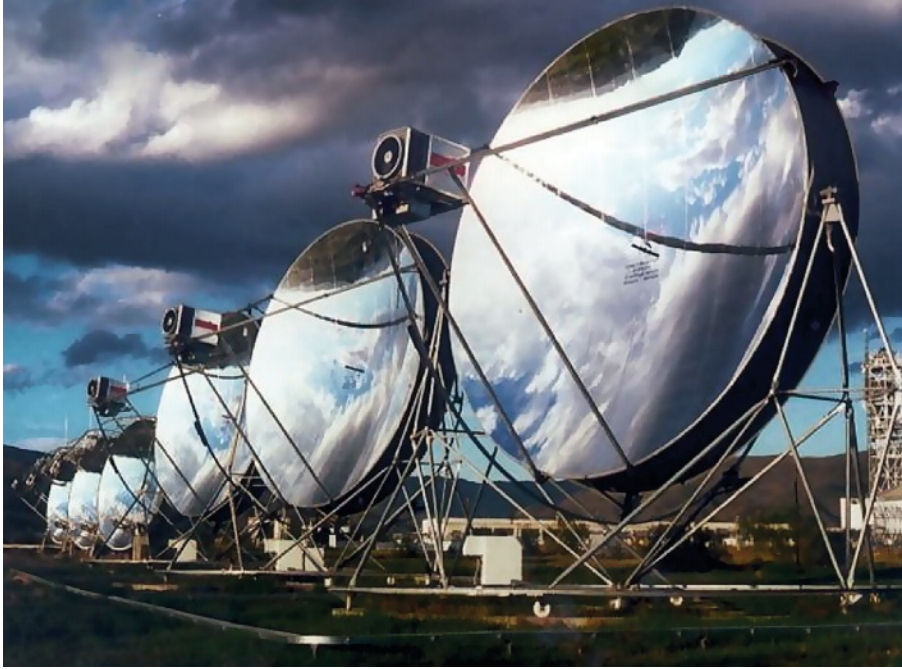
Şekil 11: Çanaklı – Stirling Motorlu Güneş Güç Santrali
