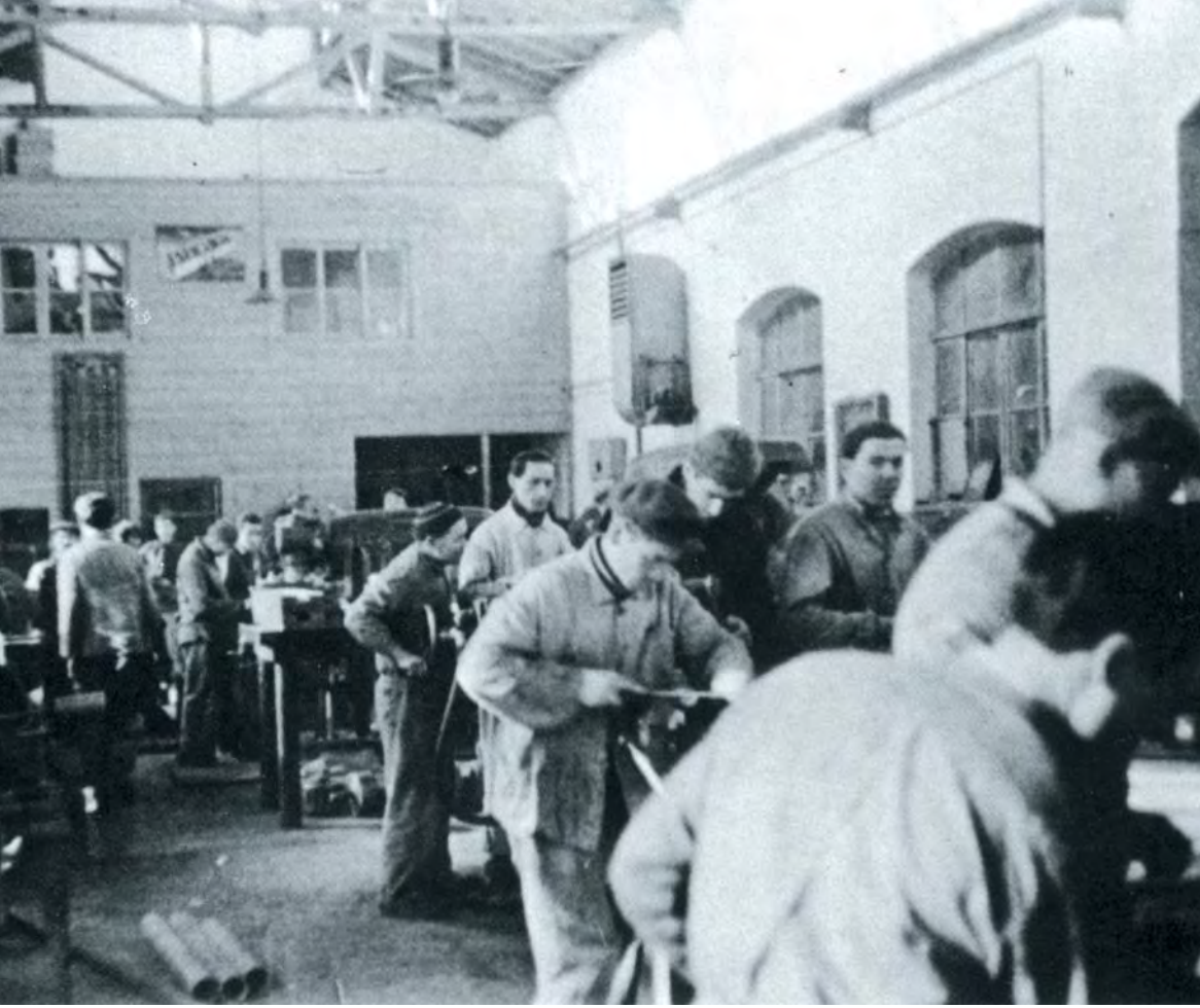
Sümerbank Beykoz Kundura ve Deri Fabrikası
