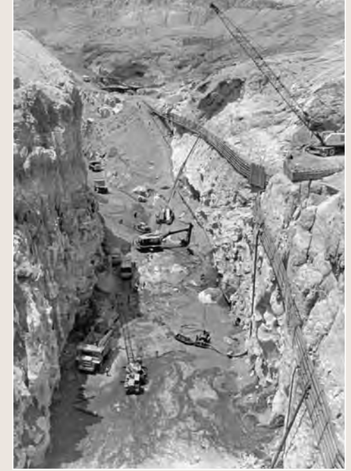
Keban baraj inşaatı.
