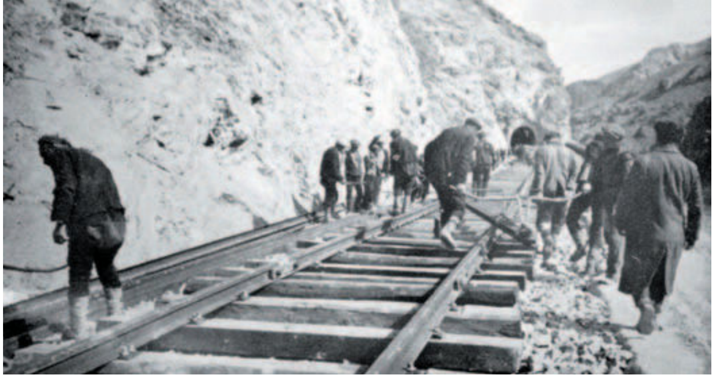
Sivas-Erzurum demiryolu döşeme çalışmaları
