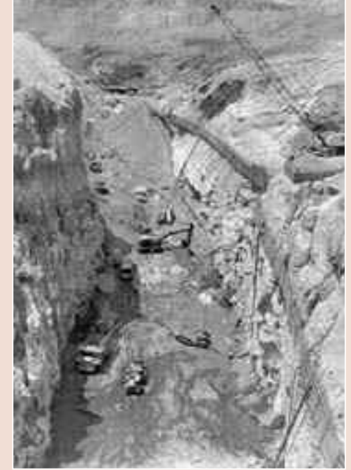
Keban baraj inşaatı.
